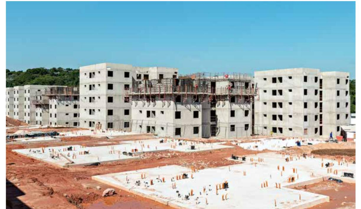
Ein Bauprojekt von Direcional Engenharia umfasst im Schnitt über tausend Wohneinheiten. Die Bauzeit für einen Wohnblock beträgt 45 Tage, den Innenausbau eingerechnet.
