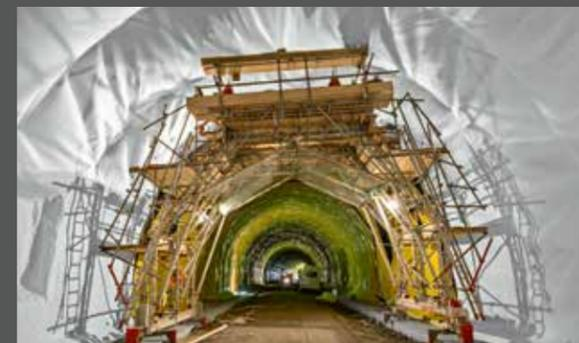
120'000 m<sup>2</sup> Sikaplan® Abdichtungsmembrane werden beim Bau des Brenner-Basistunnels eingesetzt. Der 55 km lange Tunnel zwischen Österreich und Italien wird nach seiner Fertigstellung einer der längsten Bahntunnel der Welt sein.
