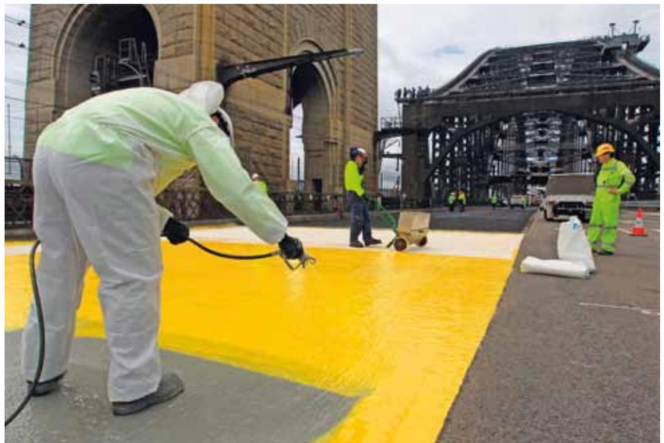
■ **Korrosion kann grosse Schäden** an tragenden Strukturen anrichten. Waterproofing-Technologien von Sika liefern effektiven und andauernden Schutz. Sie wurden speziell entwickelt für eine effiziente Durchführung von Erneuerungsarbeiten.
