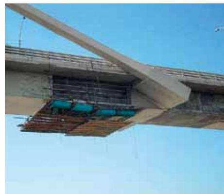
Salzwasser, Erosion und Abrasion – die Schäden waren entsprechend komplex. Mit Sika Produkten und Systemen wie Korrosionsschutz, Reparaturmörtel, Schutzanstrichen und einem Verstärkungssystem mit Kohlenstofffasergewebe konnten sie alle auf umweltverträgliche Weise behoben werden, sodass diese Brücke für die nächsten Jahrzehnte nur noch den üblichen Unterhalt braucht. ■
