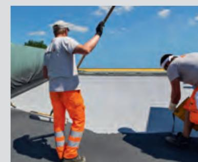
Grundieren, abdichten, schützen und versiegeln. Das Sika One Shot System macht Parkdeckbeschichtung einfach, sicher und schnell: 1'000 m<sup>2</sup> pro Tag sind leicht zu schaffen.
