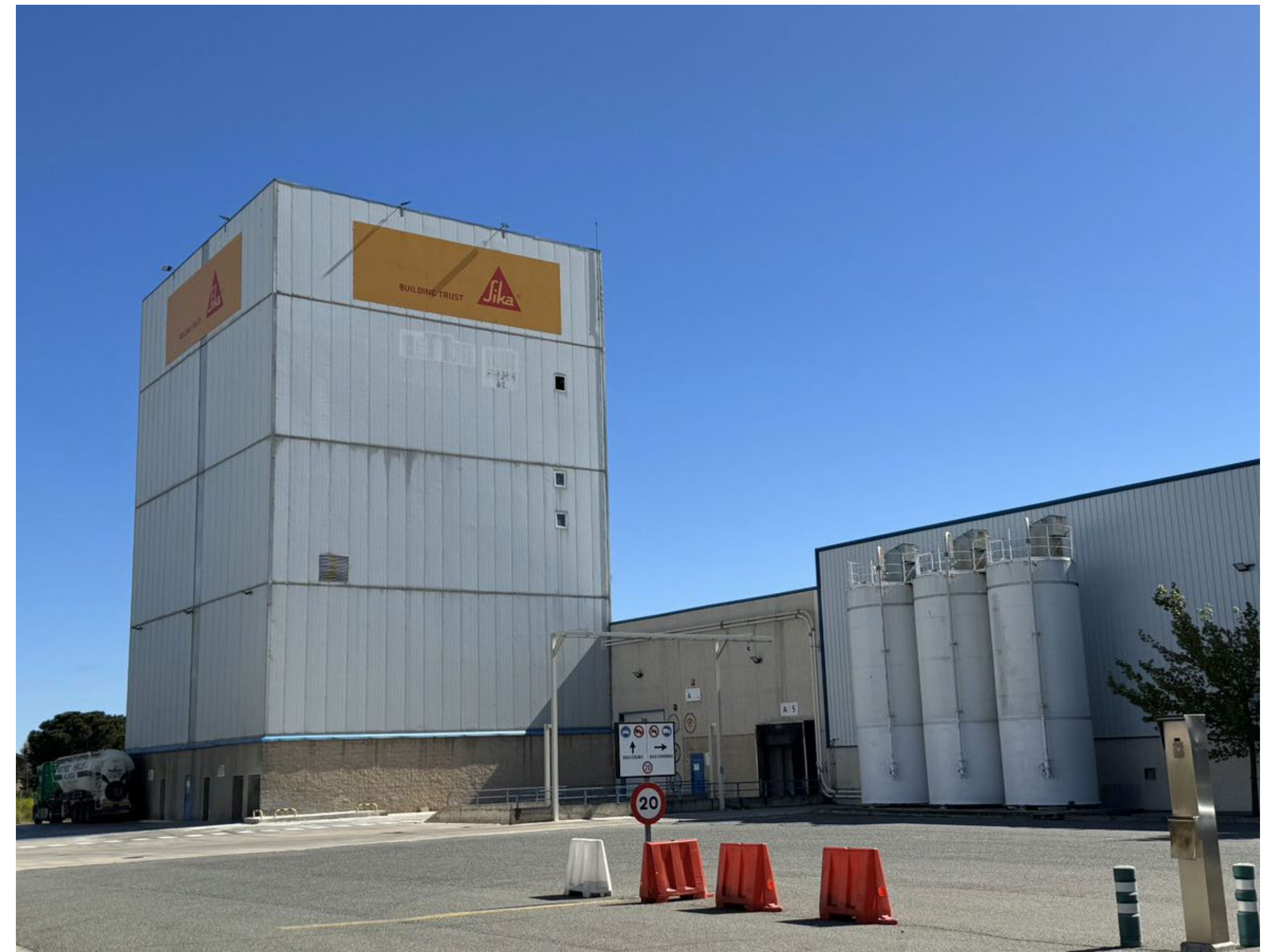
La antigua planta de MBCC en Cabanillas del Campo: La experiencia y el conocimiento conjunto de los equipos de Sika y MBCC llevó a un nuevo nivel de excelencia operativa.
