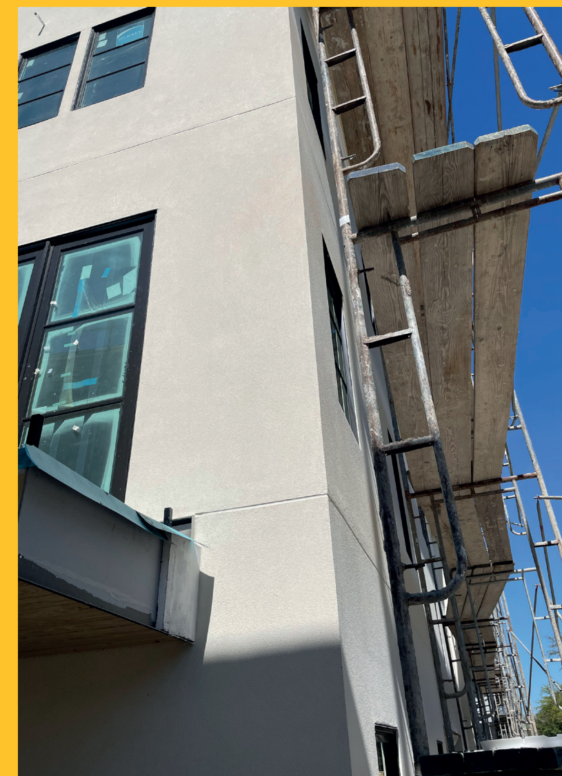
Sika U.S. se concentre sur les façades.
