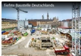
Tiefste Baustelle Deutschlands S-Bahnhof Marienhof und Linie, München, Deutschland
