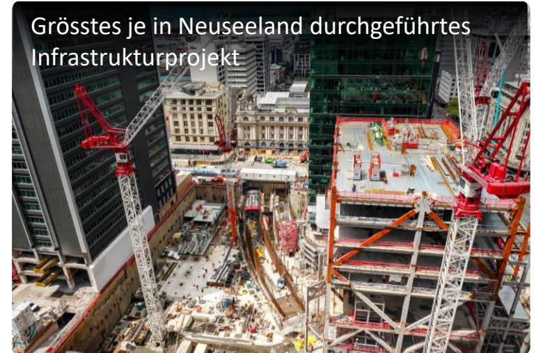
City Rail Link, Auckland, Neuseeland
